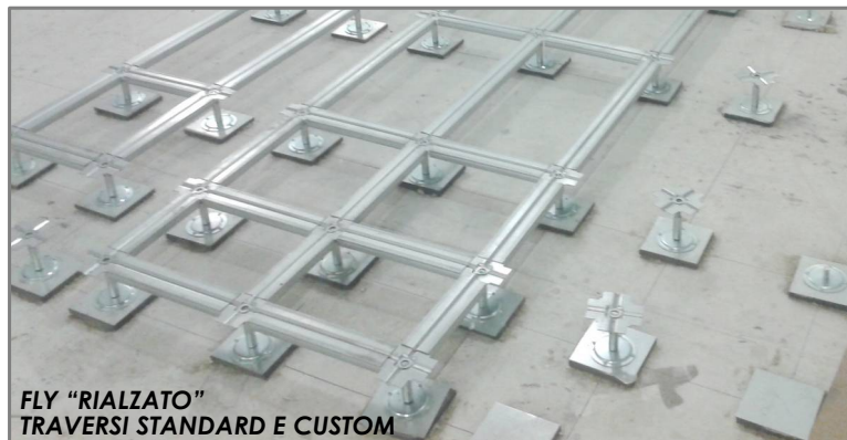
TRAVERSI CON ALETTE METALLICHE ELETTRO PUNTATE PER IL SOSTEGNO DEL COIBENTE (OPZ.)
